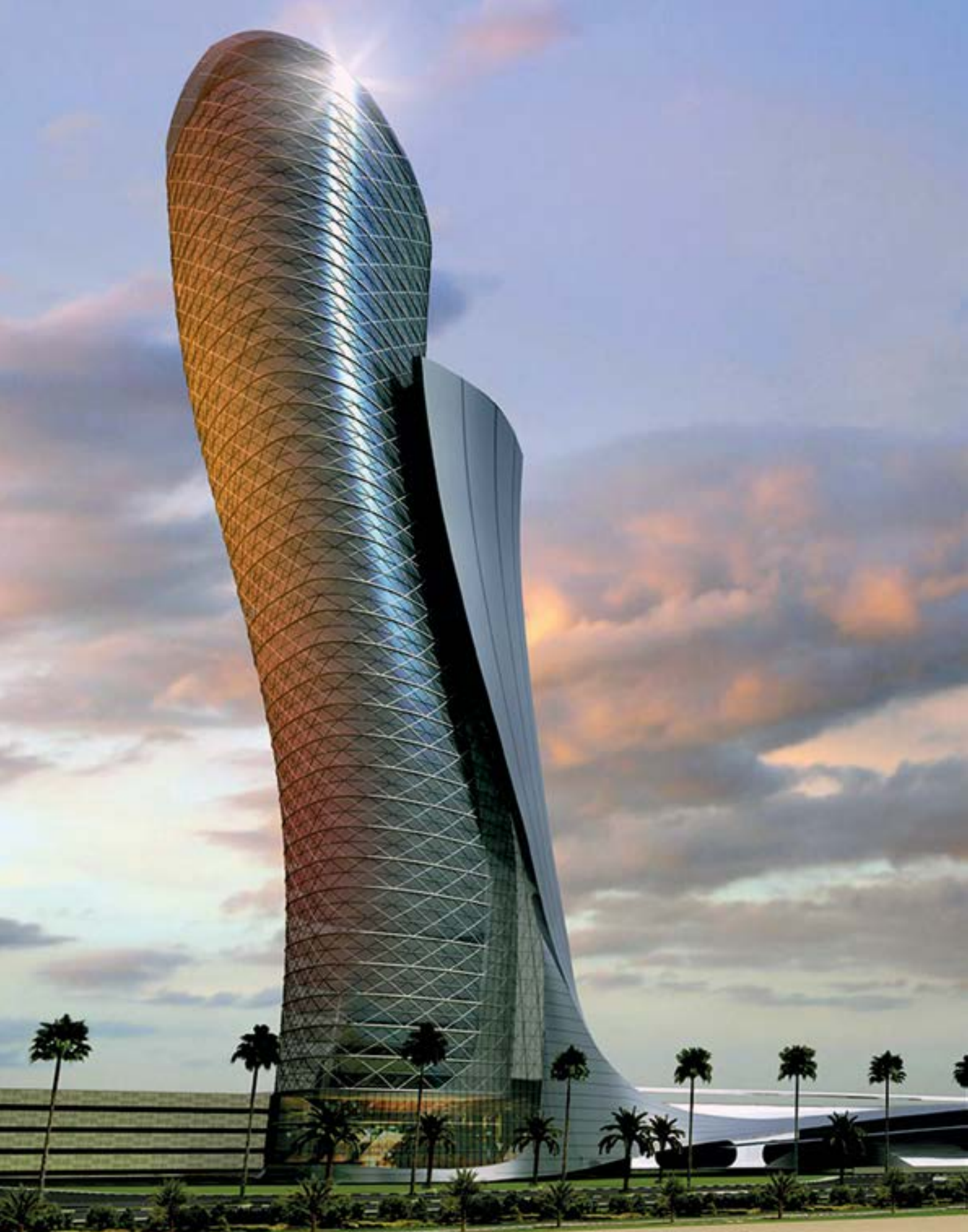
Capital Gate - Abu Dhabi (Zjednoczone Emiraty Arabskie)
